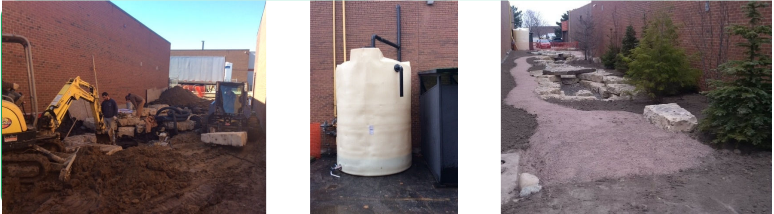
Ci-dessus, de gauche à droite : Le site de Calstone Inc. durant les travaux de construction; un des deux réservoirs de collecte des eaux de pluie; vue sur le chemin poreux et les étangs d'infiltration à partir de l'arrière des installations.
